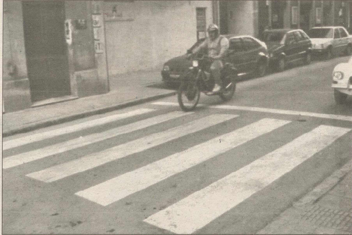
Ciudadanos han denunciado en el Ayuntamiento el riesgo de caídas por la pintura del asfalto.
