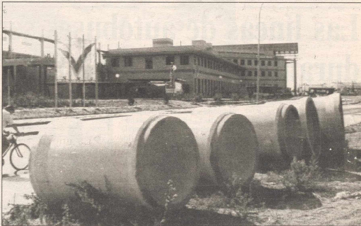
Las tuberías, que están siendo instaladas, son de mayores dimensiones
