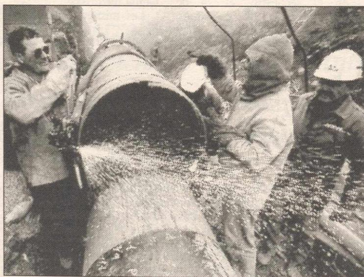
Momento en que se produce la unión de los dos tramos del gasoducto.
