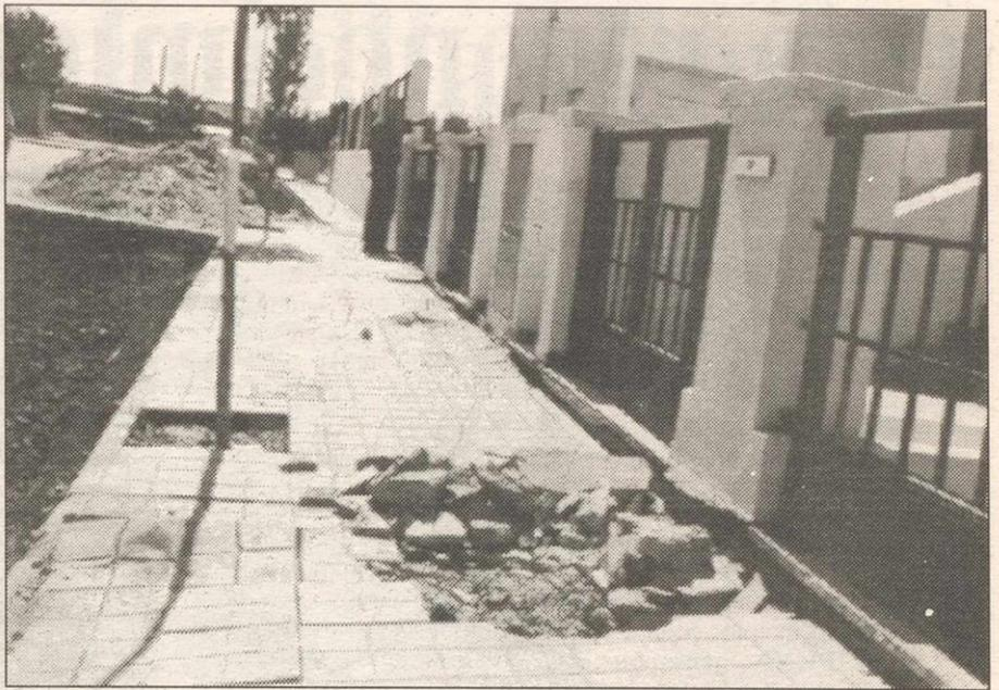
RUEDA El hundimiento del pavimento también ha provocado el levantamiento del acerado
