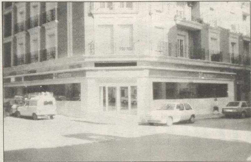
FACHADA ASEPEYO VALDEPEÑAS
