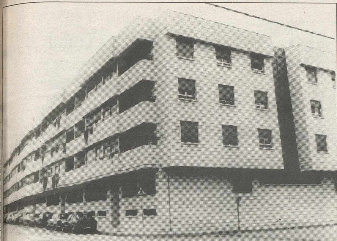
Las consultas y reclamaciones en la OMIC en relación con el sector vivienda sufrieron un destacado aumento.
