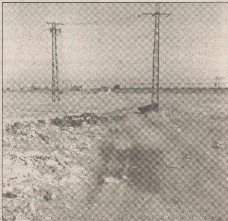
Los accesos a la estación son casi inexistentes.
