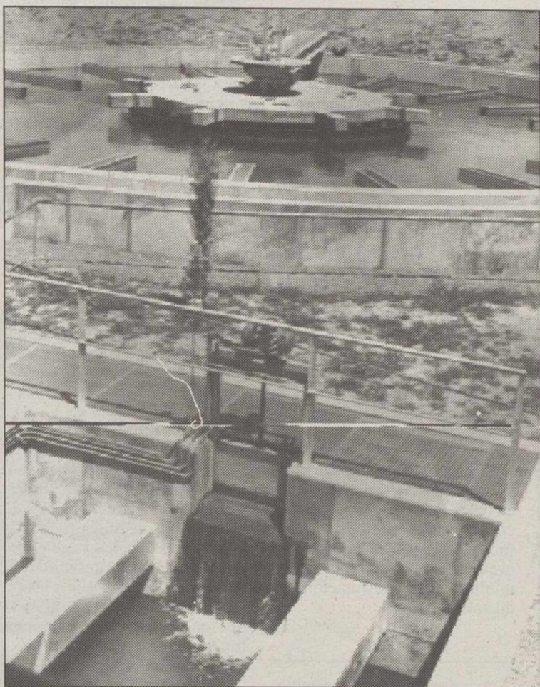
Nueva planta potabilizadora.
