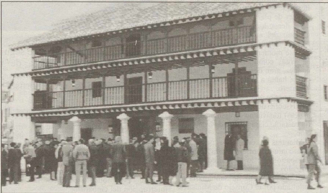
La Posada de los Portales de Tomelloso, tras las obras.
