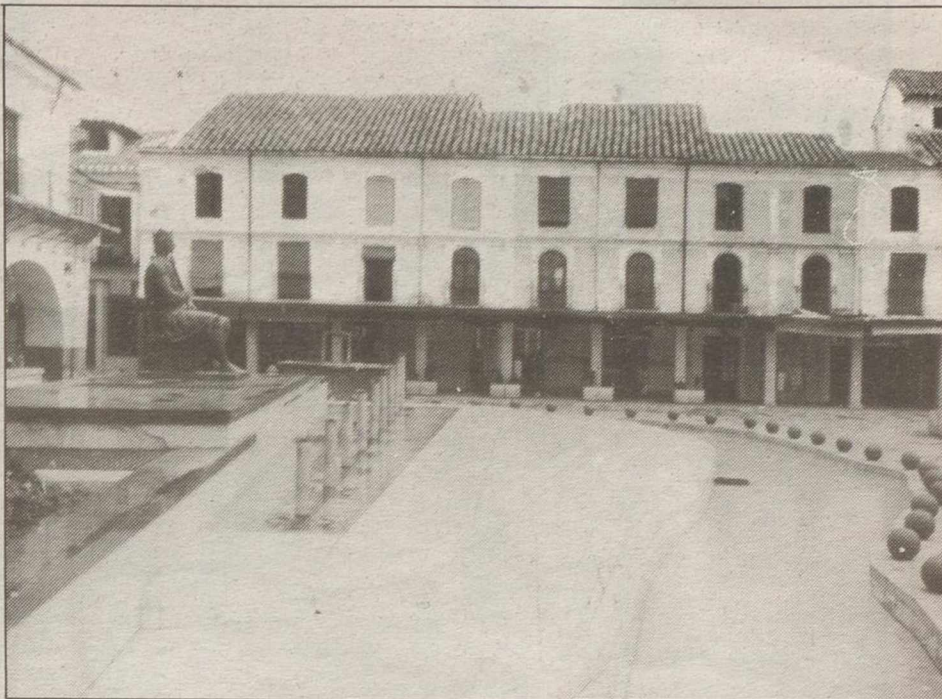
En la actualidad la diferencia entre este barrio y la zona centro de la ciudad es muy grande.
