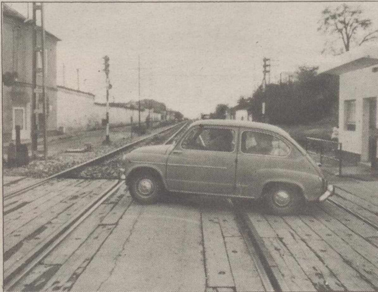
Conflictivo paso a nivel en Socuéllamos. JESUS MORENO.
