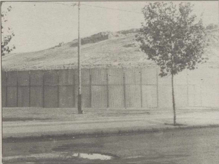
La plaza instalada en Puertollano.
