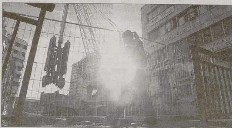
Las obras de la Estación de Autobuses volverán a traer cambios de tráfico. / M. REINO
