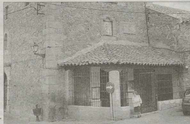
La fachada de la Iglesia del Cristo ha sido recientemente restaurada. / C.S.
