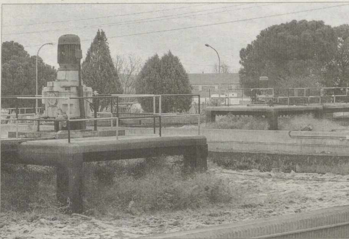
El PSOE lamenta que el Gobierno no sepa el estado en el que están obras como la de la depuradora del Polígono. VALDIVIELSO
