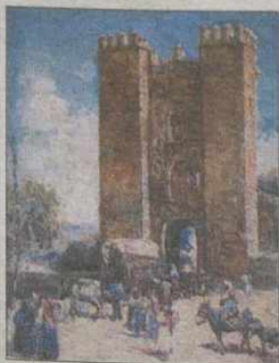
Entrada al puente de Alcántara.
