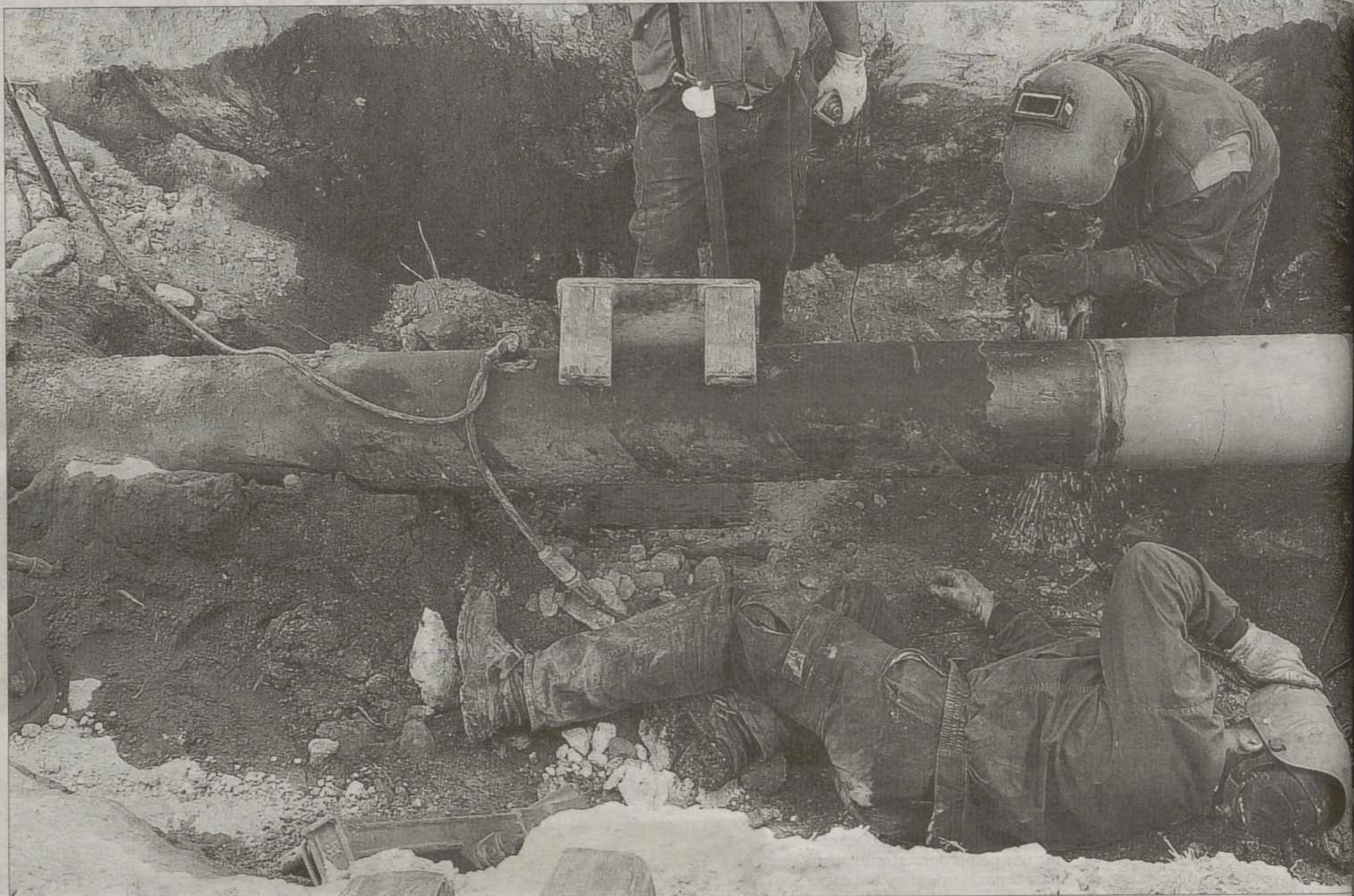
Los operarios de CLH terminaron a primera hora de la tarde de soldar el tramo nuevo, después aún había que recubrir la tubería para protegerla de la corrosión y tapar el agujero. / FOTOS: EVA GARRIDO
