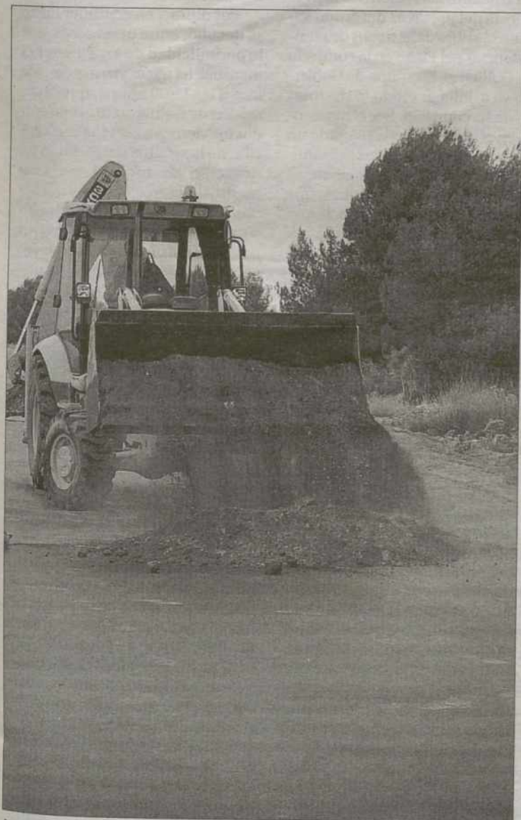
Las tareas de limpieza se iniciaron con la retirada de la tierra contaminada.
