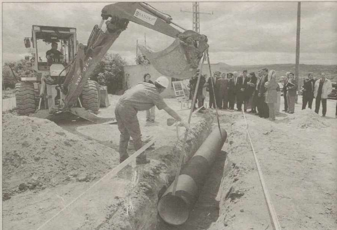
Las obras comenzaron el 11 de abril, con la presencia de la ministra de Medio Ambiente. / YOLANDA LANCHAS
