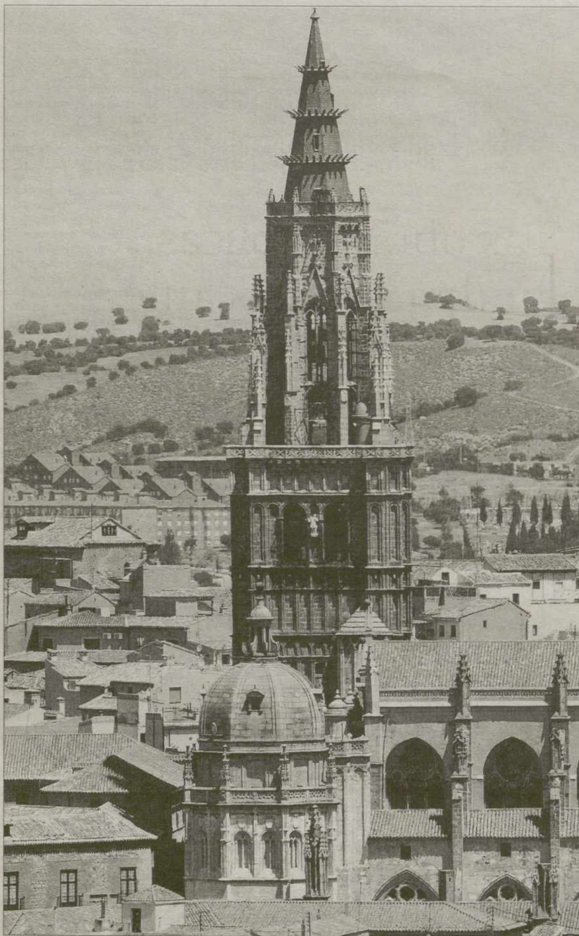
La falta de estanqueidad en las cubiertas ha provocado diversos daños en las bóvedas. / EVA GARRIDO
