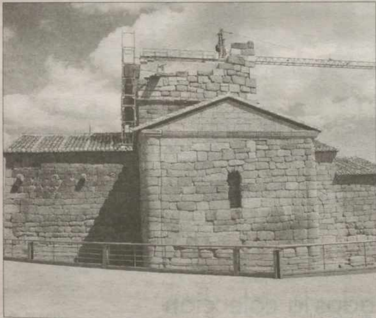
Estado actual de las obras de restauración. / D.P.
