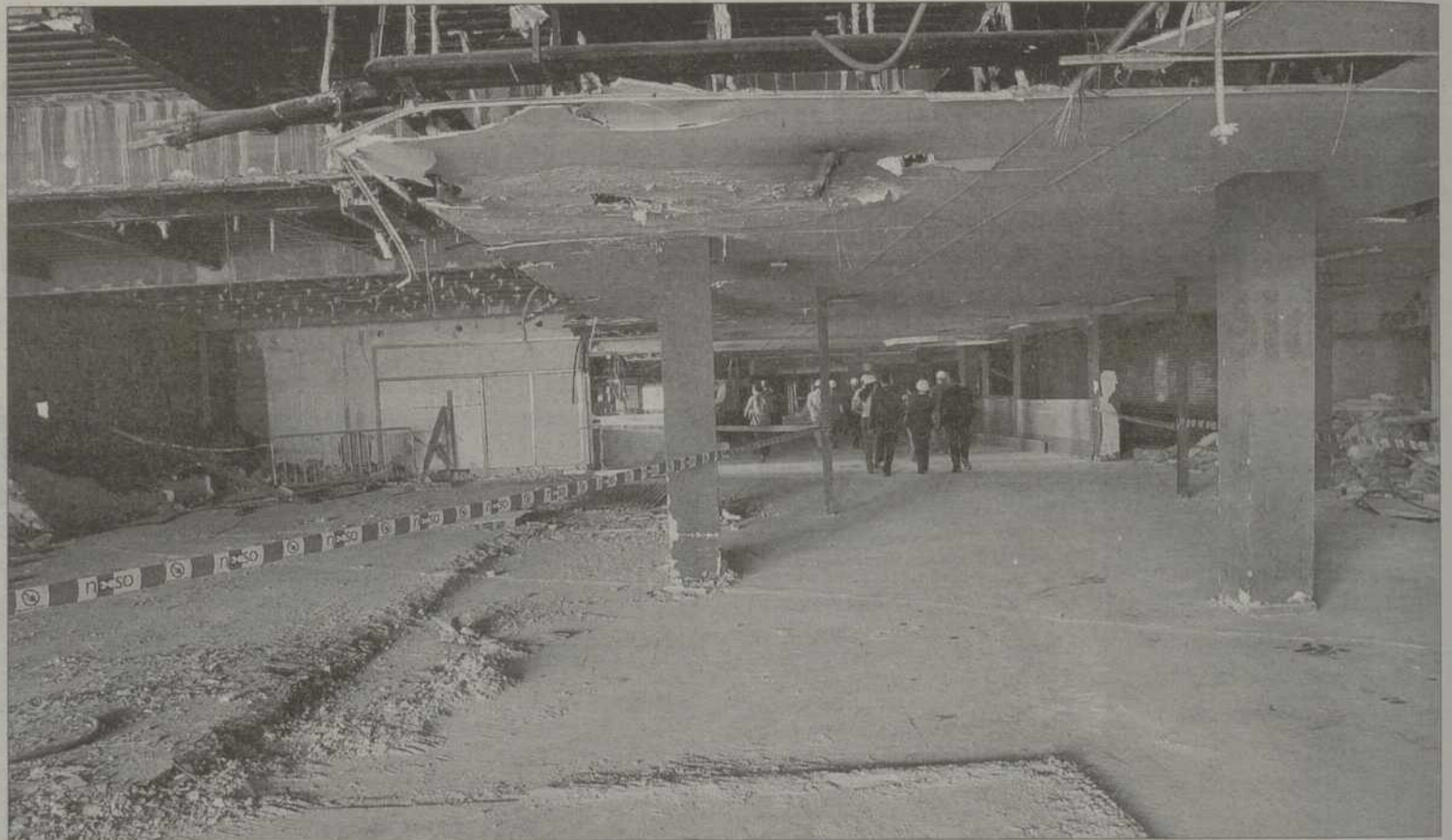
Las obras han comenzado retirando los tabiques interiores y al tiempo que se prepara la excavación en la roca del Miradero. / VALDIVIELSO
