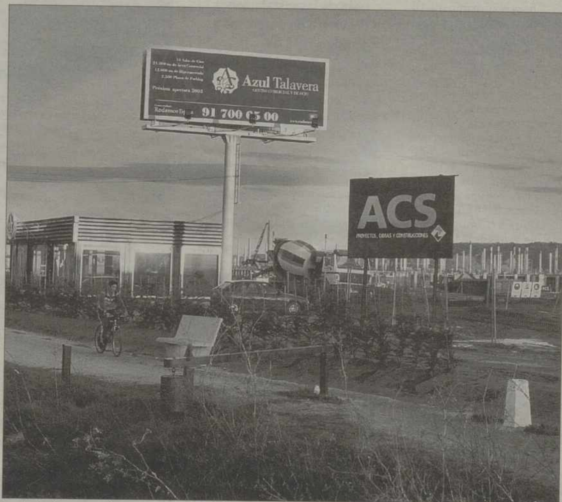
Las lluvias han retrasado los trabajos de estructura y cimentación, por lo que la inauguración se retrasará. /R. VIADERO
