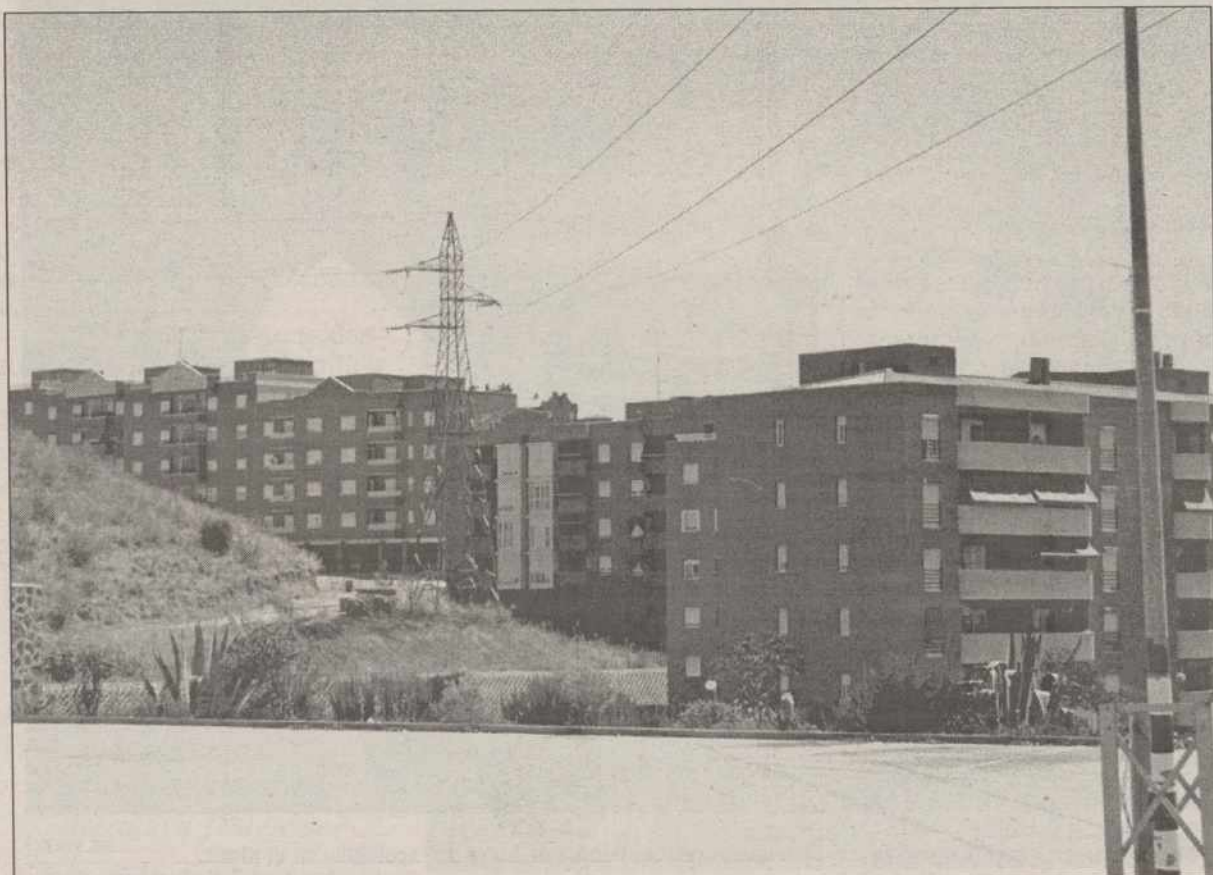
La línea de alta tensión de Buenavista debía retirarse antes del 13 de junio, según prometió Conde. Y. LANCHAS
