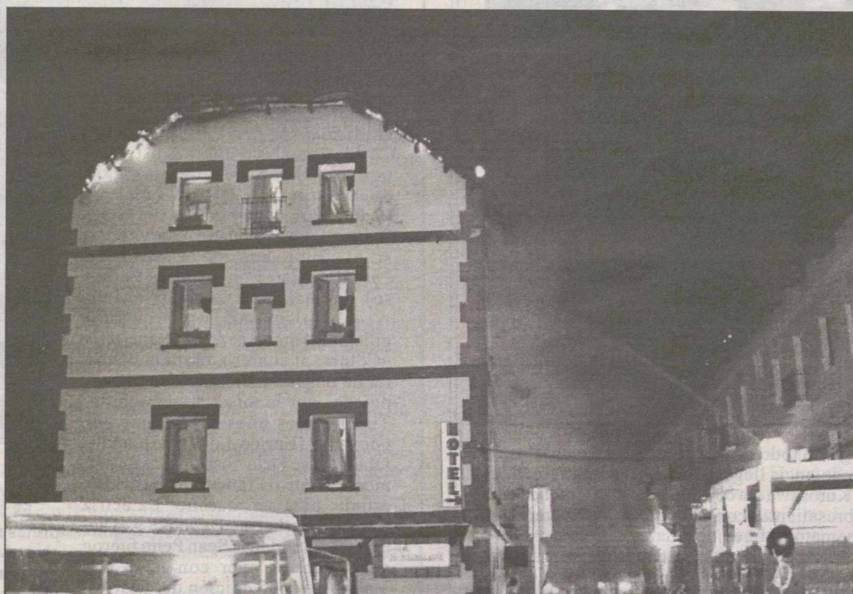
Estado en el que quedó el hotel incendiado en Huesca.
