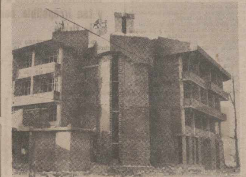
Estado de las obras del Hotel «Fuentes Carrionas». (Foto BENEDICTO)
