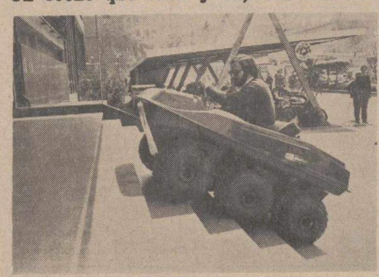
El vehículo que más ha llamado la atención en el Salón Internacional del Automóvil es este que vemos en la fotografía, un prototipo fabricado por un industrial barcelonés al que ha bautizado con el nombre de «Gato Montés». Tiene seis ruedas y es anfibio. Sube y baja las escaleras con gran facilidad, alcanza sobre el agua seis kilómetros por hora y sobre tierra 60. Aquí le vemos haciendo una demostración (FOTOFIEL)
