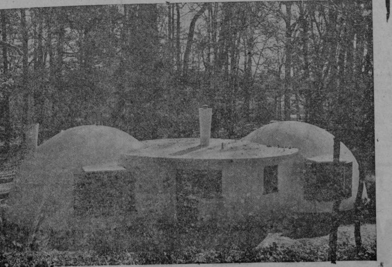
Las casas de reciente construcción en los EE. UU. Para cada una de las secciones semiesféricas se infla un semiglobo de lona y caucho, una vez sujeto a los miembros de la casa, se rocía el hormigón sobre su superficie. Una vez fraguado éste, el globo se desinfla.
