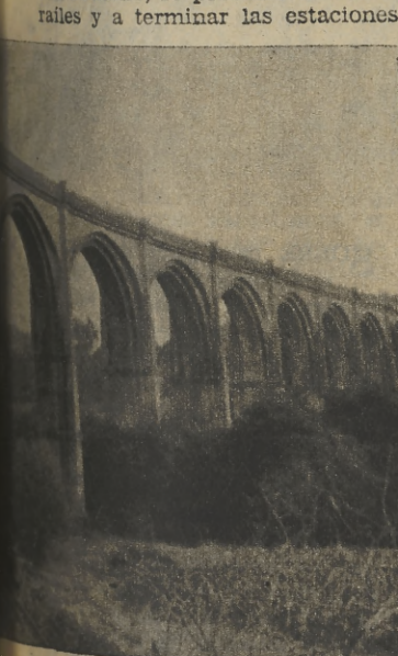
Dos aspectos de las obras del nuevo ferrocarril. El viaducto de Pumarino mide 181 metros de longitud
