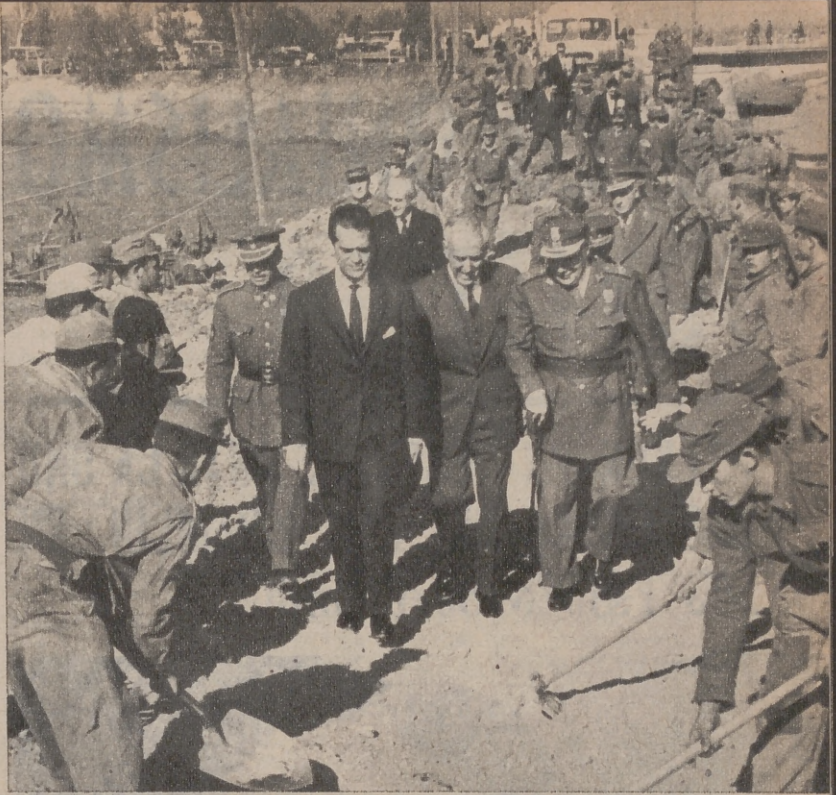
El Ministro señor Gual Villalbi, en su visita a las obras de reparación del muro de contención del Tamarguillo, acompañado de las autoridades sevillanas
