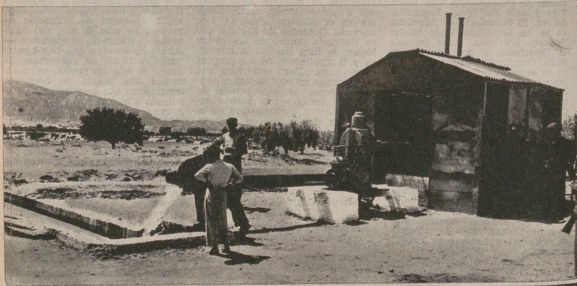
Una red de acequias reparte el agua extraída hasta las nuevas huertas y sembrados
