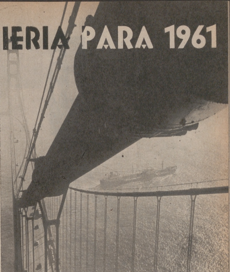
El Golden Gate, con sus 1.280 metros de luz, sigue siendo el mayor de los construidos hasta la fecha
