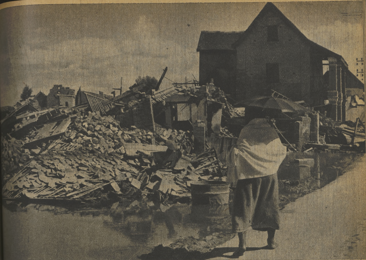
Numerosas edificaciones se vinieron abajo ante el empuje arrollador de las aguas. Los ríos se desbordaron también
