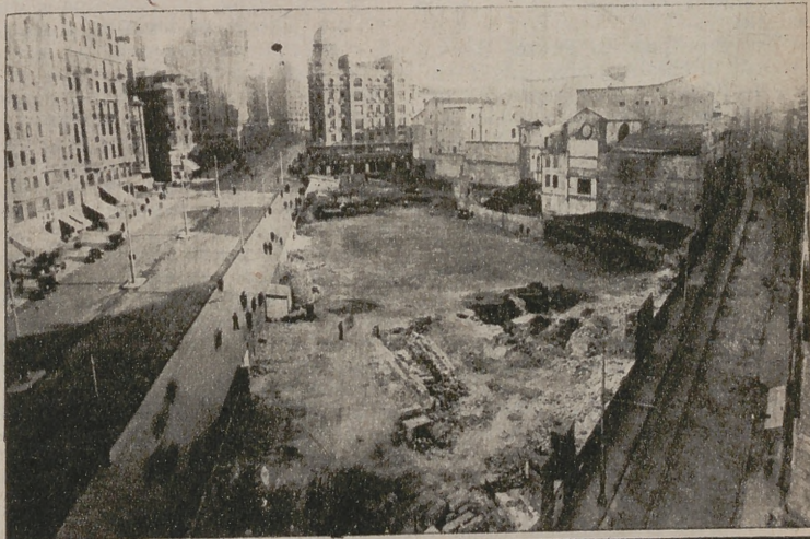
Madrid 1944. Este es el solar donde hoy se levanta el bloque Lope de Vega
