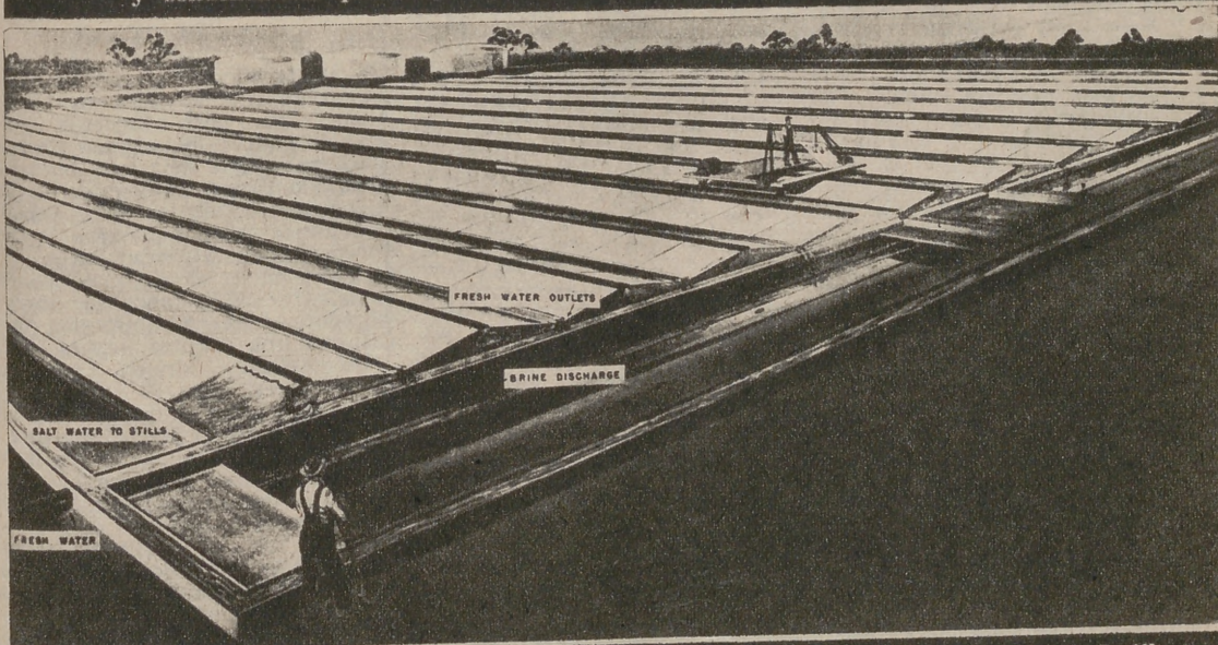
El dibujo muestra la nueva central cerca de Daytona Beach (Florida), para destilar agua marina y hacerla potable
