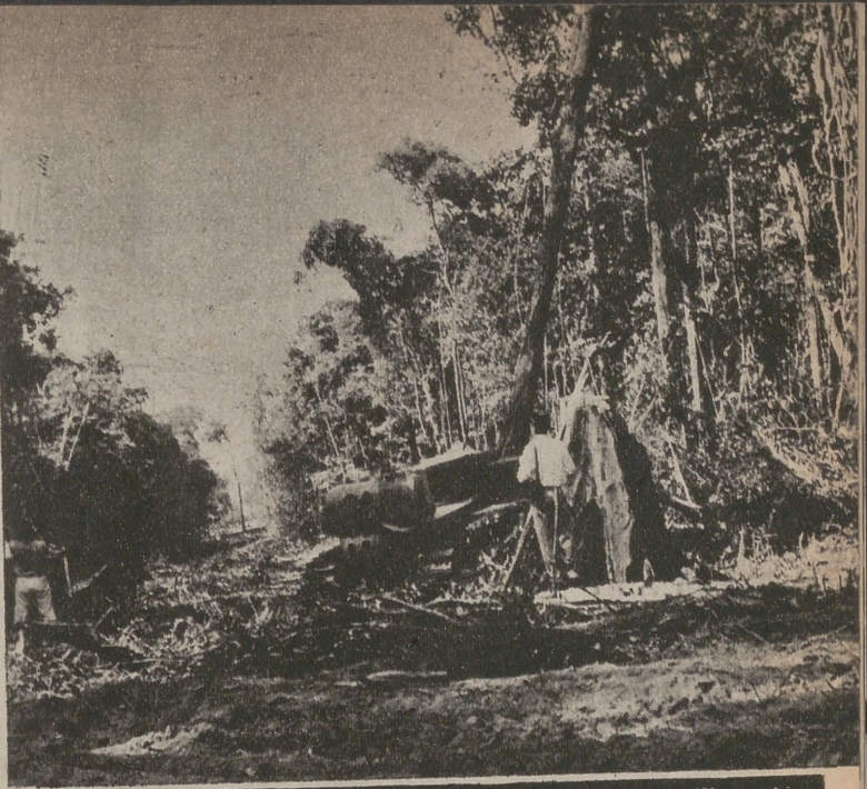
La carretera de Belem a la nueva ciudad de Brasilia está siendo trazada abriendo paso por las selvas del Amazonas
