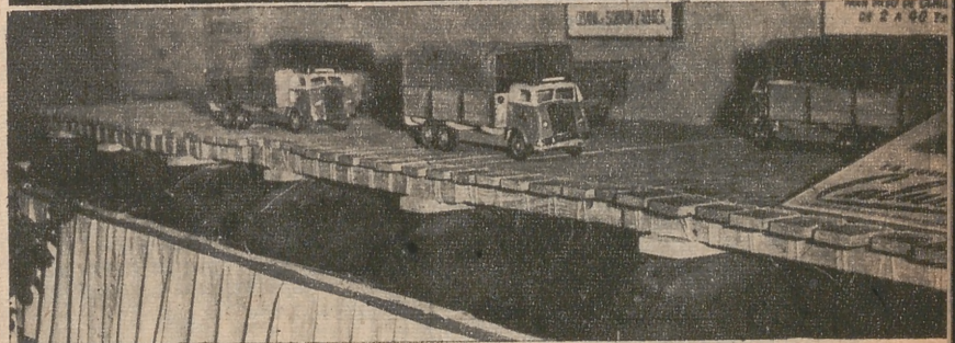
Pontones con impregnación a presión para tender puentes que permiten el paso de camiones
