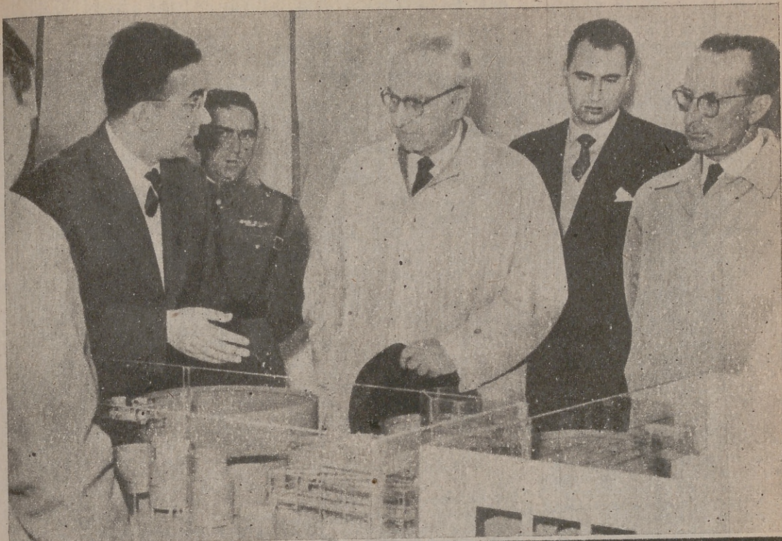
El Ministro de Industria, señor Planell, ha visitado recientemente en Andújar (Jaén) las obras de la primera planta de uranio. Aquí lo vemos estudiando las instalaciones sobre la maqueta
