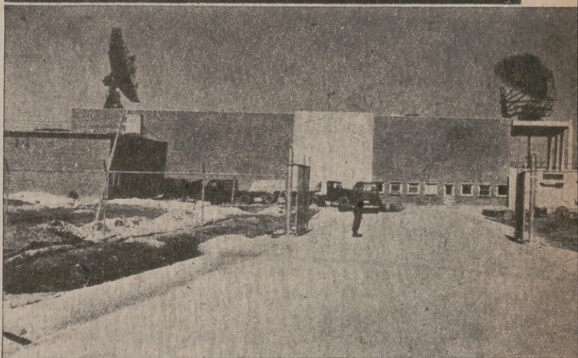
Dos grandes antenas girando incesantemente, en continua alerta, vigilan el cielo en la primera emisora española de radar instalada en Villatobas (Toledo)
