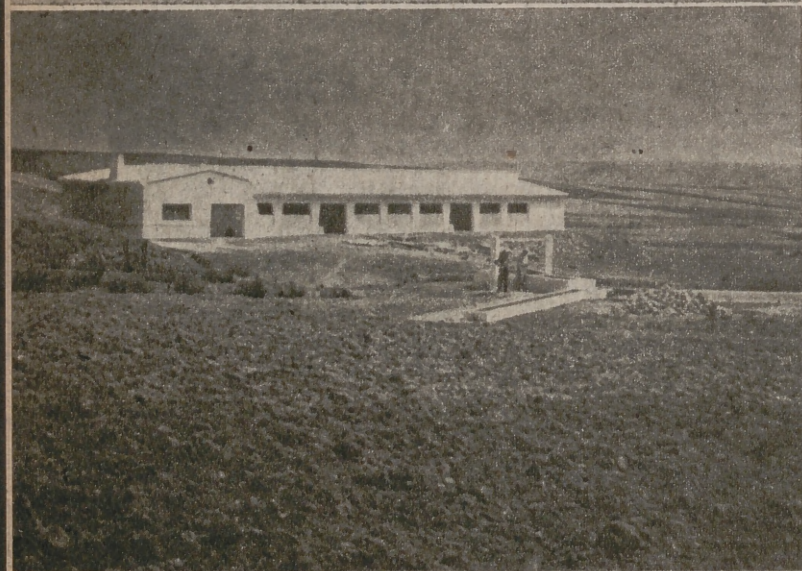
Aprisco y abrevadero de ganado construido por la Obra de Concentración Parcelaria en Olivares de Júcar
