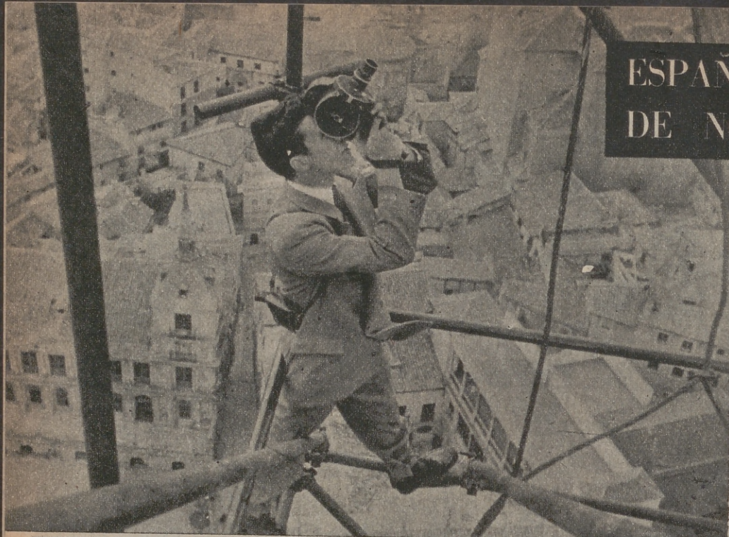
Operadores de No-Do en los andamios levantados sobre la torre de la catedral de Toledo
