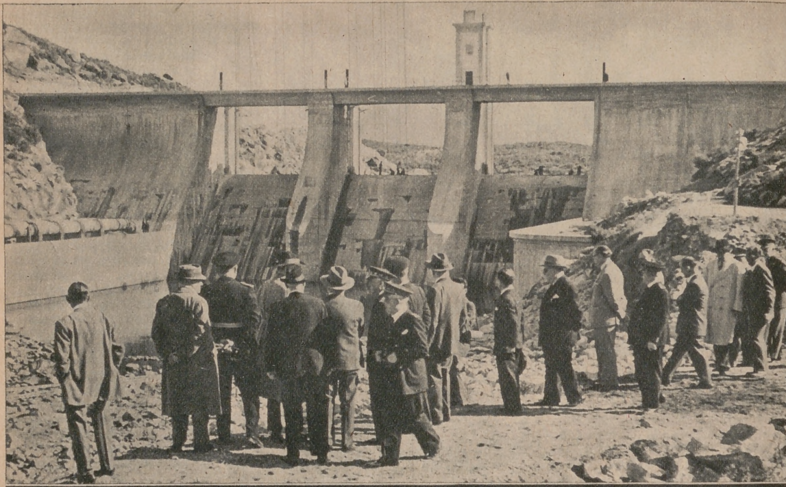
Las obras del pantano «El Rosarito», visitadas por autoridades. Está a punto de concluirse
