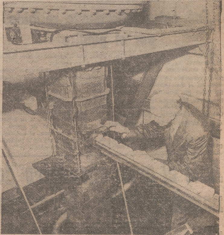
Un técnico de la General Electric prepara unas botellas plásticas flexibles para ser bombardeadas con electrones originados en unas máquinas de rayos X de un millón de voltios. Después de su exposición a los electrones las botellas resisten la esterilización por vapor, que las capacita para contener productos farmacéuticos y fluidos biológicos. El haz electrónico puede esterilizar de manera efectiva el pan, los vegetales y otros alimentos para que permanezcan frescos por largos períodos de tiempo.
