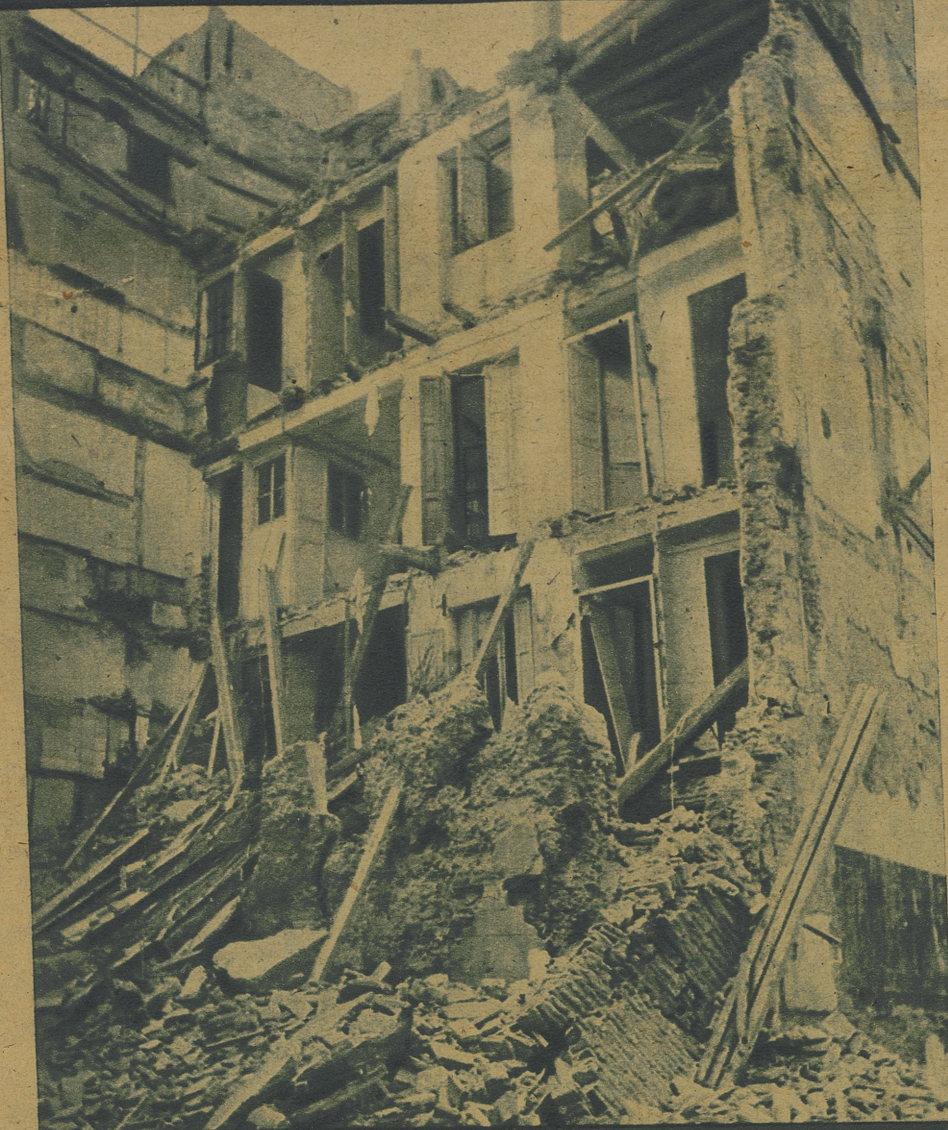
El pasado lunes, a las ocho y media de la mañana, se derrumbó la parte trasera de la casa número 7 de la calle En Colom, a consecuencia de la pertinaz lluvia de la noche anterior. Afortunadamente no ocurrieron desgracias personales. En la foto, estado en que quedó el edificio (Foto L. Vidal.)
