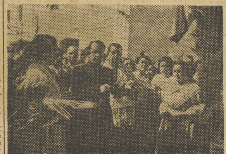
El gobernador civil corta las cintas simbólicas de acceso a las nuevas obras y mejoras realizadas. (Fotos Finzas)
