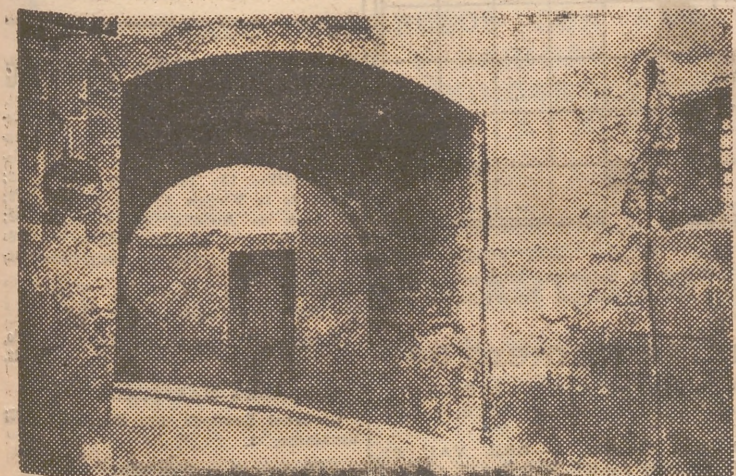
Pared del edificio derribado, con el Portal de Valldigna
