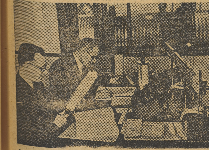
Los técnicos trabajan minuciosamente los cables que han de ser instalados bajo el mar.—(Foto Cifra.)
