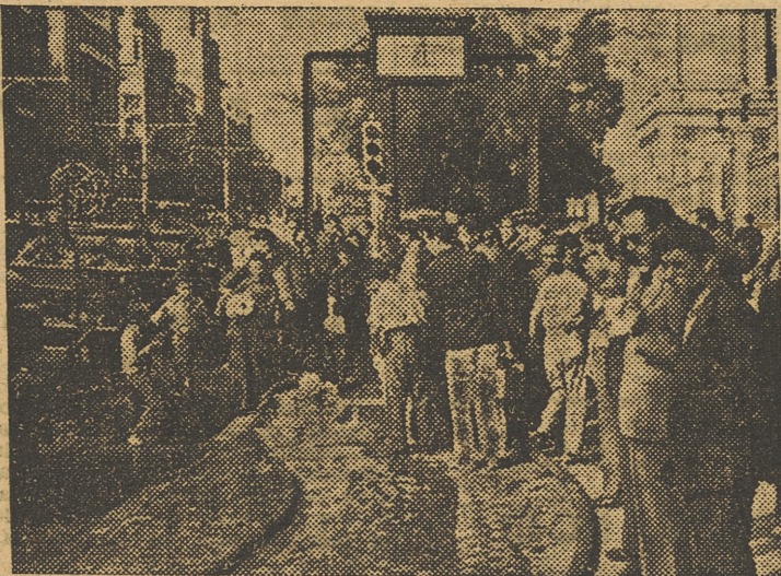
A consecuencia de la enorme tormenta que ayer descargó sobre Madrid, las calles se convirtieron en verdaderos ríos, lo que motivó rotura de conducciones de agua, que, unida a la que penetraba por los accesos al Metro, éste se inundó en la línea Sol-Ventas, teniendo que actuar los bomberos.— La foto representa una de las entradas al Metro, con las mangas funcionando para desaguarla. — (Foto Vidal)
