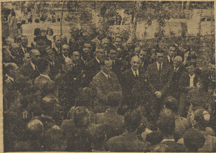
En la visita efectuada a las obras del Preventorio Infantil de Campanar, el camarada Carceller dirige a los obreros una vibrante alocución.—Foto Finezas.
