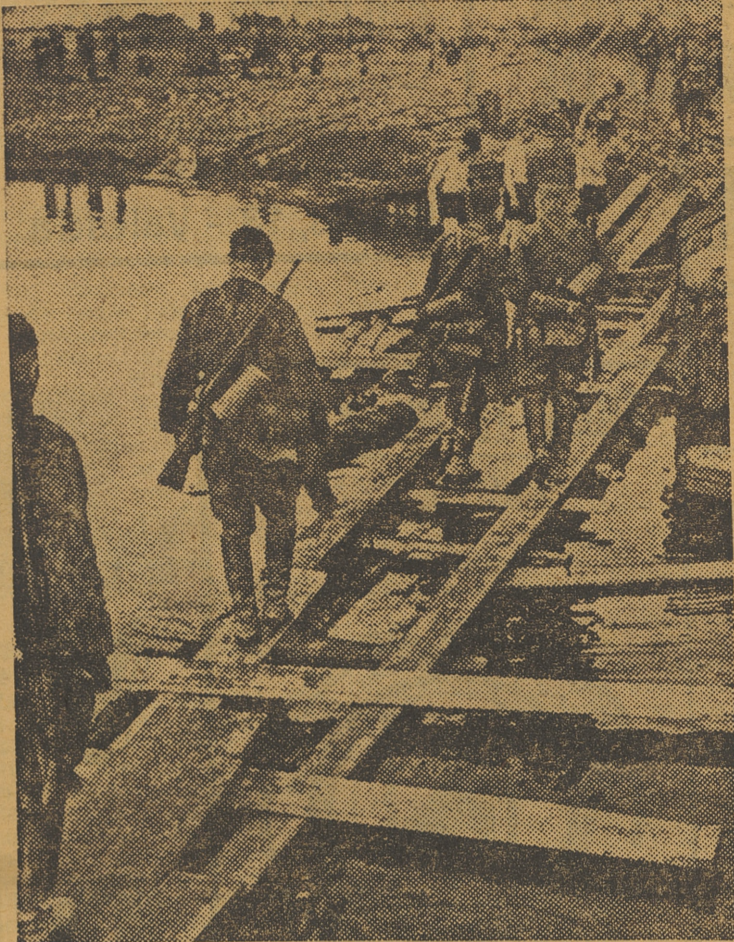
Pese a los esfuerzos destructores rusos, las tropas del Reich prosiguen su avance incontenible. La Infantería alemana atraviesa el Narew, sobre un puente construido por los ingenieros en sustitución del volado por los rusos
