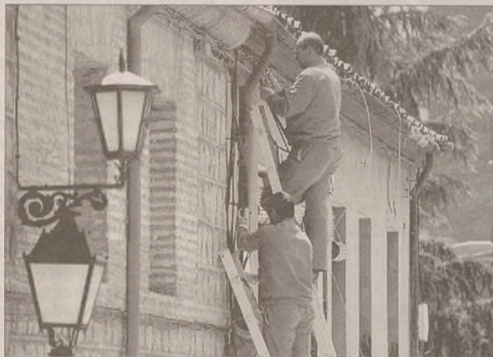
Electricistas arreglan la instalación de una fachada.
