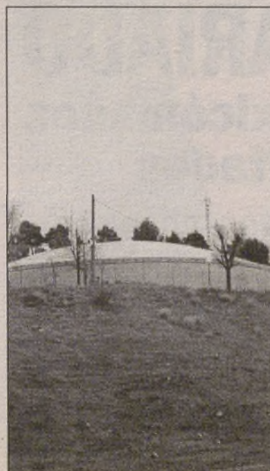
Vaciado un depósito.
