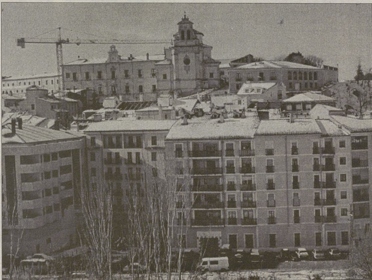
En la provincia de Cuenca se han construido 405 viviendas de promoción pública.
