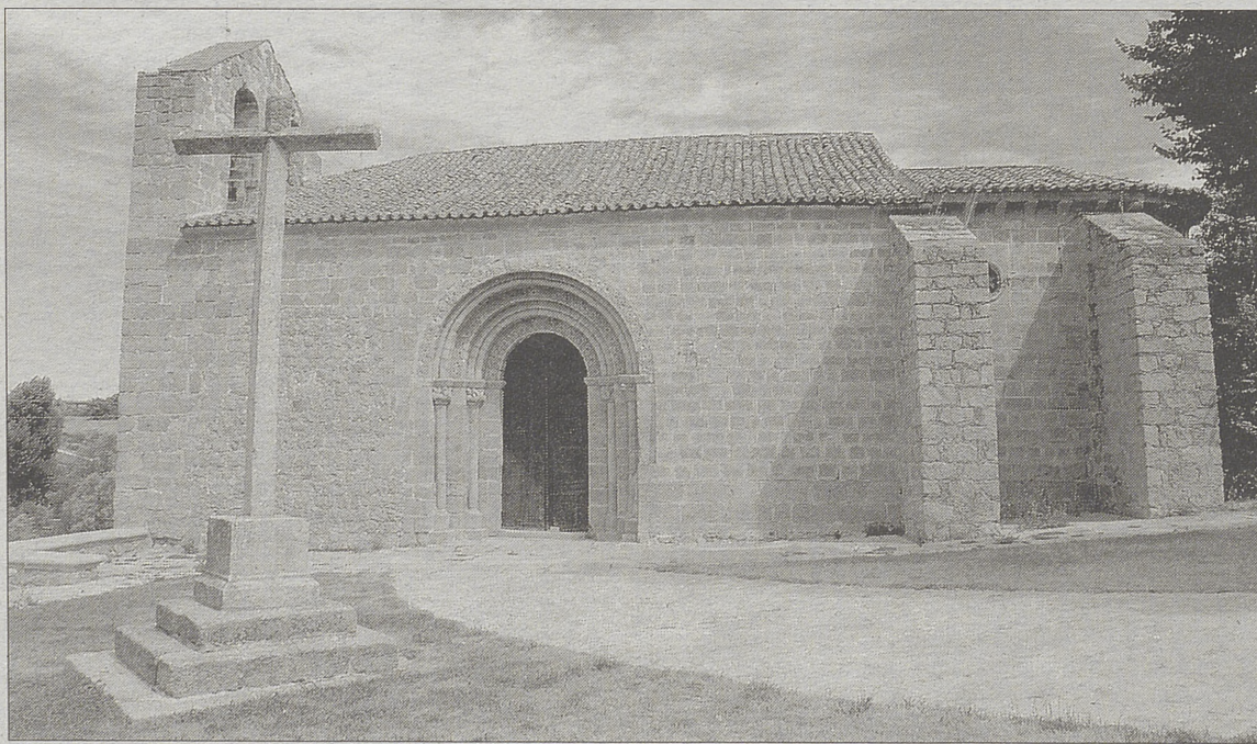
Junto al puente del río Adaja se encuentra la iglesia de San Segundo, consagrada al primer obispo de Ávila. / A. SAN ROMÁN
