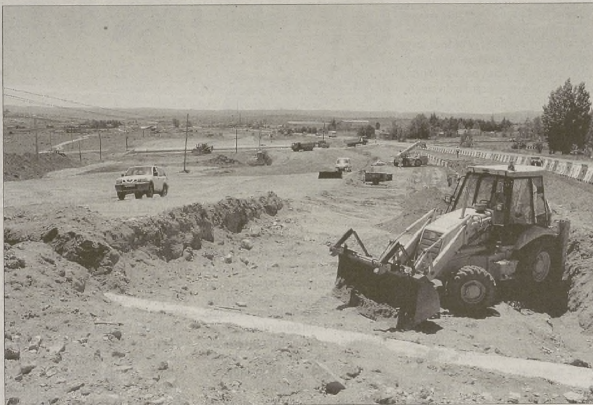
Imagen de las obras de la A-50 (Ávila-Salamanca). /DAVID CASTRO
