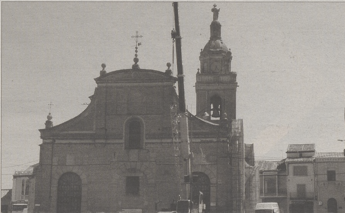
Rehabilitación de la parte sur del tejado de la parroquia arevalense. /DE LA FUENTE
