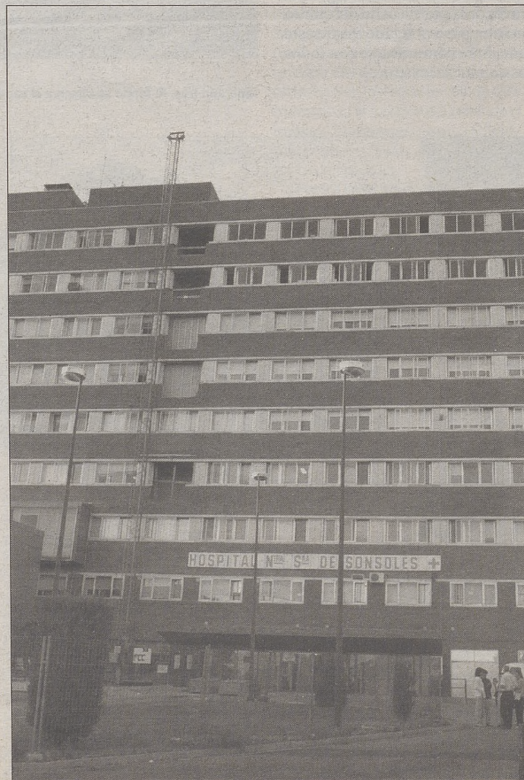
Fachada del Hospital de Nuestra Señora de Sonsoles.
