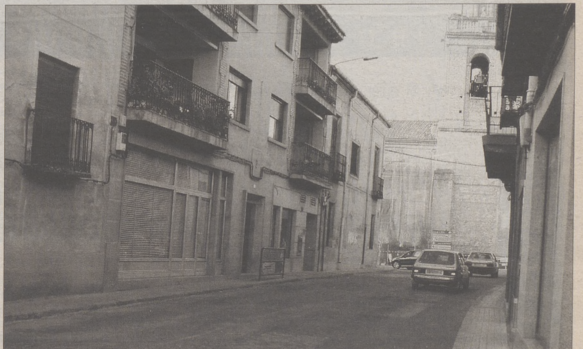
Imagen actual de la calle Caldereros de Arévalo. /DE LA FUENTE
